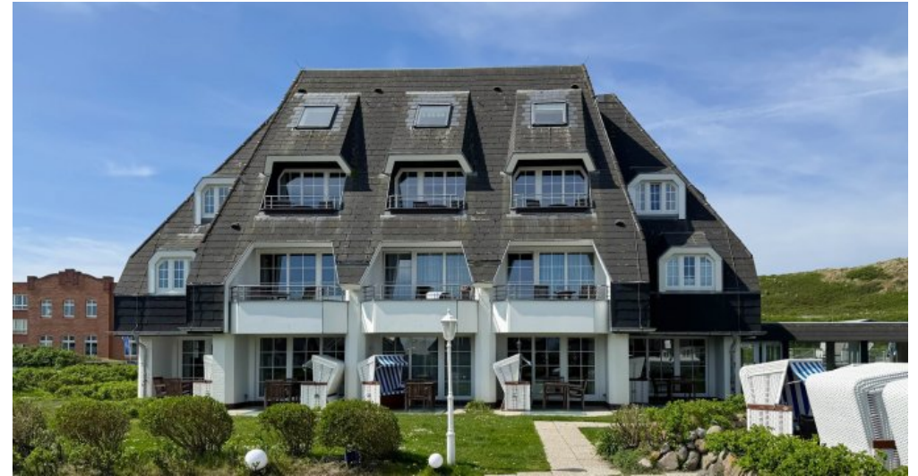
Gesamtansicht Haus II Osten
